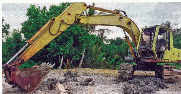
ALAT pengorek jengkaut inilah yang telah menghempap Azemi ketika sedang melakukan kerja-kerja menanam tiang konkrit di tapak pembinaan sebuah rumah di Kampung Seberang, Kuala Jerlun, Jitra semalam
