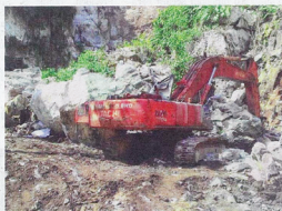
KEADATAN jengkaut yang dihempap bongkah batu seberat lebih 30 tan di sebuah kuari di Sungai Raya, Keramat Pulai, Ipo, semalam.
