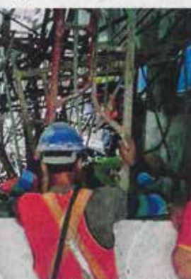
PEKERJA binaan membantu mengalihkan besi perancah yang jatuh.
