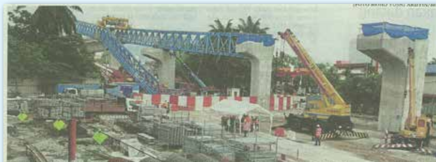
Gelangsar gantri tumbang dan menggelangsar diri landasan di tapak projek landasan MRT Luluau Sungai Buloh-Serdang-Putrajaya di Jinjang, malam kelmarin.
